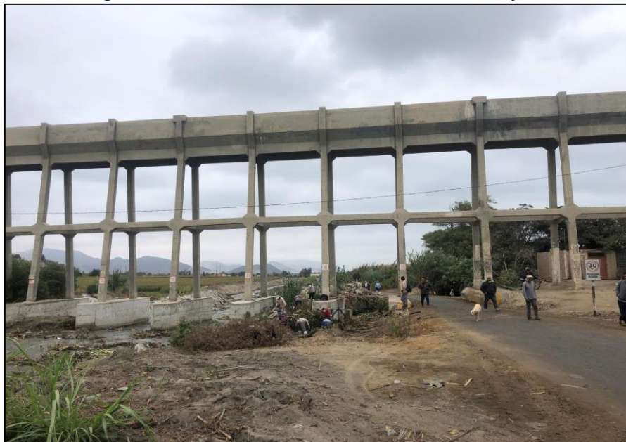
Imagen 4: Cruce con canal Aéreo altura CP Cascajal
