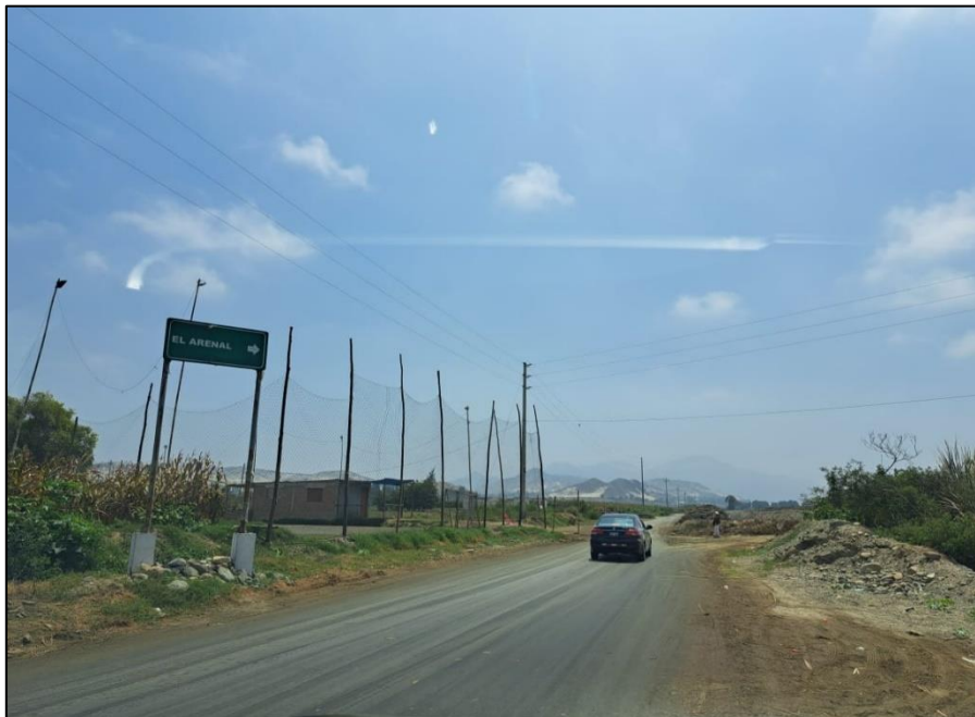
Imagen 3: Tramo Cambio Puente hacia Subproyectos
