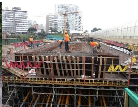
Mejoramiento del Puente Villena Rey
