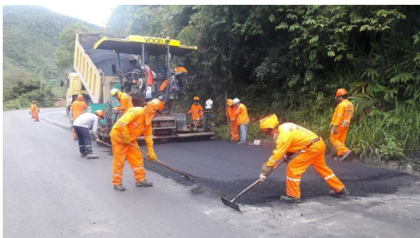
Reciclado y Recapeo de la carretera Huánuco
