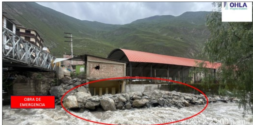
Figura N°5_ Obra de Emergencia
